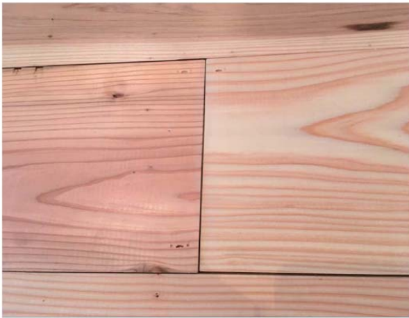
ステーブルの天打ち部分 塗装前
