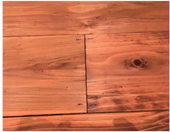
ステーブルの天打ち部分 塗装後
