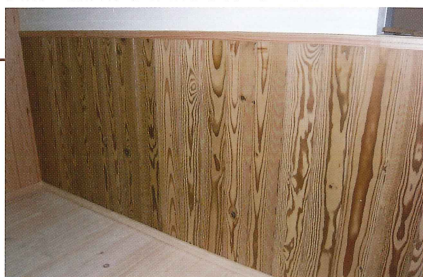
中国木材(株)展示室 ペイマツ腰壁
