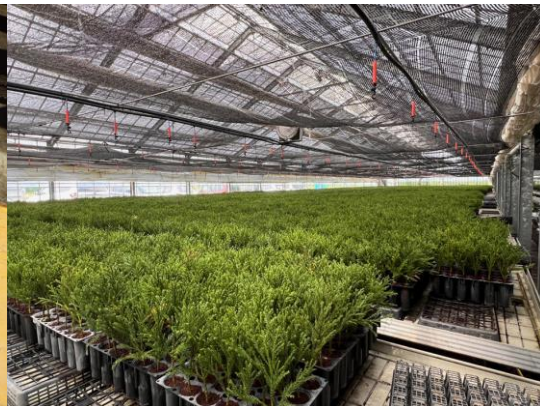
スプリンクラーを備えた育苗棟
